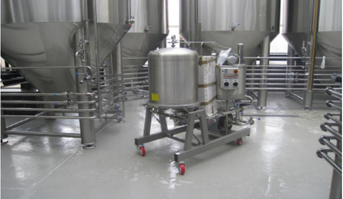
Sono definiti, molto semplicemente, con i termini *epossi-cemento* o *poliuretano-cemento*. I prodotti così ottenuti presentano caratteristiche chimico-fisiche particolari; ciò è vero soprattutto per i poliuretano-cemento, la cui resistenza chimica e agli shock termici fa sì che siano ampiamente utilizzati nelle aziende chimiche e alimentari.
