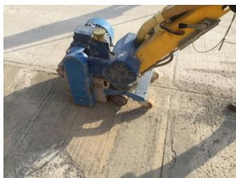
Su un tamburo multi-albero vengono montati utensili liberi di ruotare sugli alberi stessi; il tamburo ruota facendo impattare gli utensili sulla superficie della pavimentazione. Tale azione comporta l’asportazione di uno strato superficiale della pavimentazione, la cui profondità può essere regolata grazie ad apposite leve presenti sull’attrezzatura.
